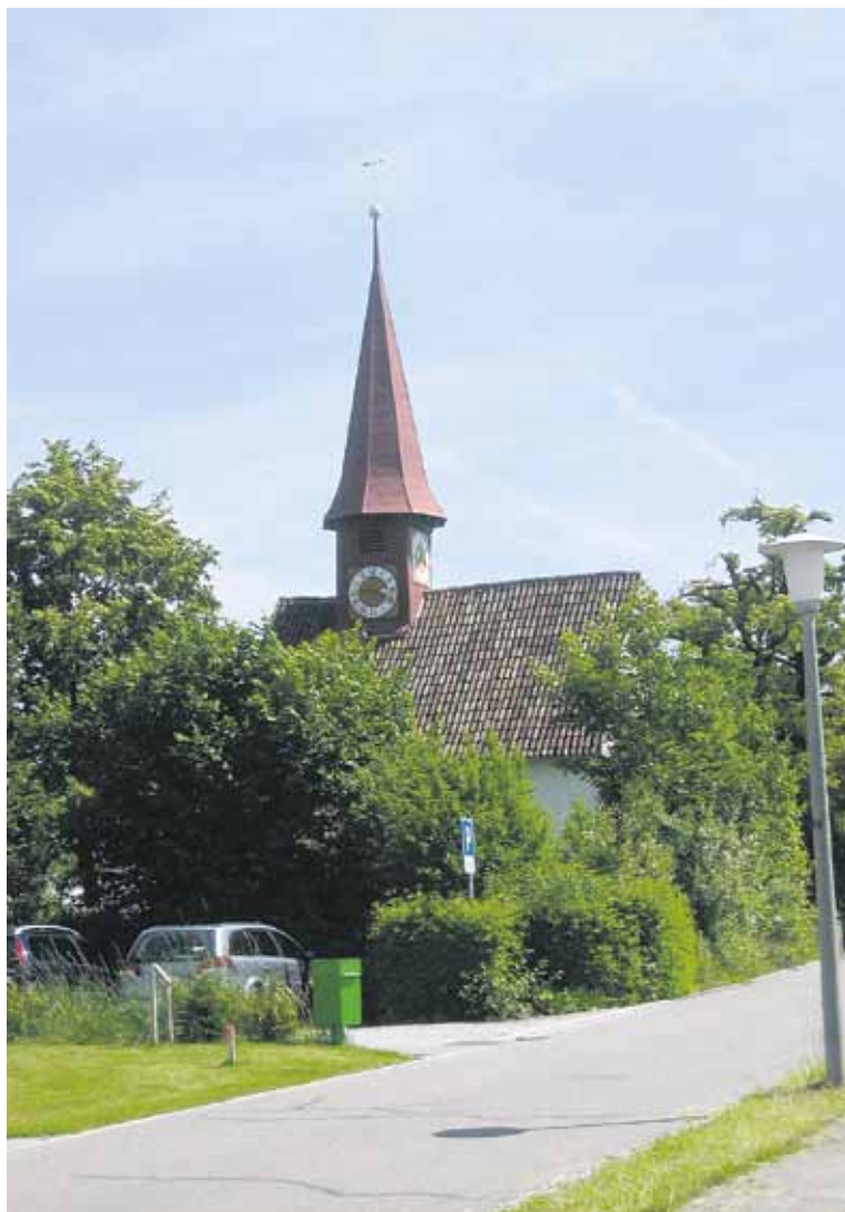
Die St. Oswald-Kapelle in Breite steht unter Bundesschutz.
