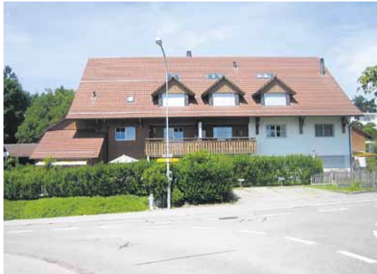
Das Bauernhaus an der Dorfstrasse 26 von 1551 musste einem Neubau weichen. (Bilder: Christian Weiss)
