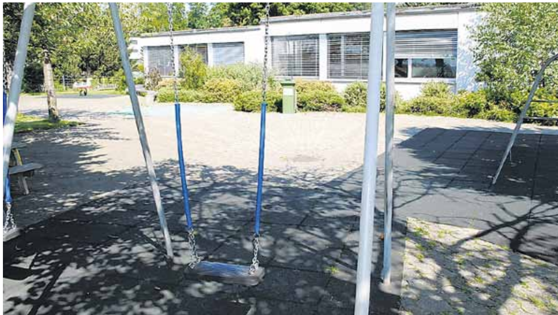
Der Kindergarten Sunnerain in Birchwil wird im kommenden Jahr abgebrochen; an seiner Stelle entsteht ein Neubau. (ar)
